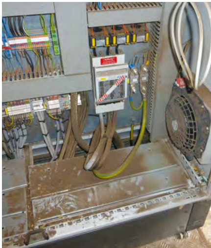
Bild 11 / Starke Staubablagerungen sind ein häufiges Problem bis in die Schaltschränke hinein.
