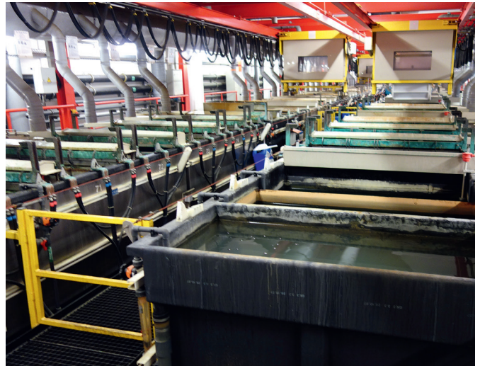
Typischer Galvanikbetrieb mit hintereinander angeordneten Behältern sowie Absaug- und Abluftanlagen.
