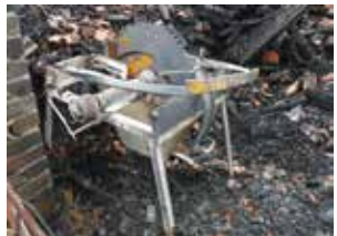
Ursache: Zuleitungskabel zur Kreissäge
