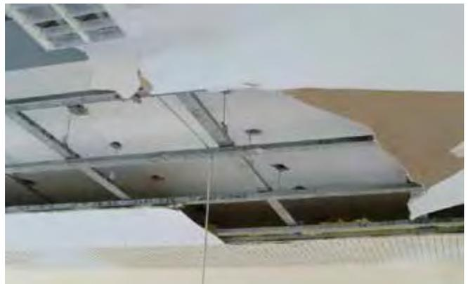
Der Leitungswasserschaden im Stockwerk darüber weichte die Decke auf. Wegen der Feuchteschäden in den Wänden, Decken und Böden mussten diese sofort getrocknet werden, um Schimmelwachstum zu vermeiden. Weitergehende Aufwendungen und Absperrungen wären ansonsten erforderlich geworden.
