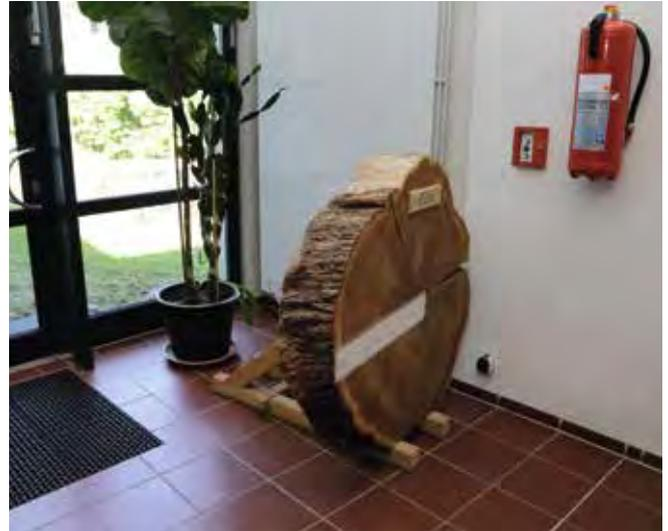
Bild: Treppenhautsituation: Der Feuerlöscher hängt etwas zu hoch. Die Dekoration behindert Fluchtweg und Zugang zum Feuerlöscher.
