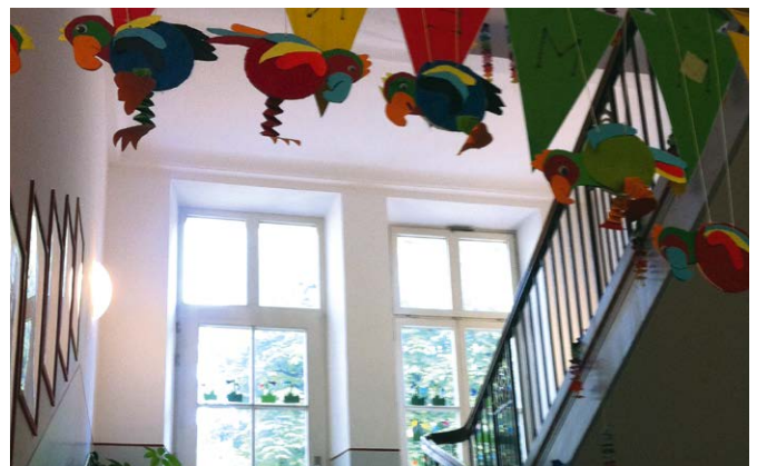
Dekorationen im Treppenraum sollten mit Augenmaß geschehen, brennbare Materialien vermieden werden. Die hier dargestellte Situation ist grenzwertig.
