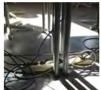
Überlastete Mehrfachsteckdosen bergen ein hohes Brandrisiko. Empfehlenswert sind Qualitätssteckdosen, die nur mit dem maximal zulässigen Wert belastet werden. Besser sind vom Elektriker fest verlegte Leitungen. Rechtes Bild: Eine häufige anzutreffende Situation.
