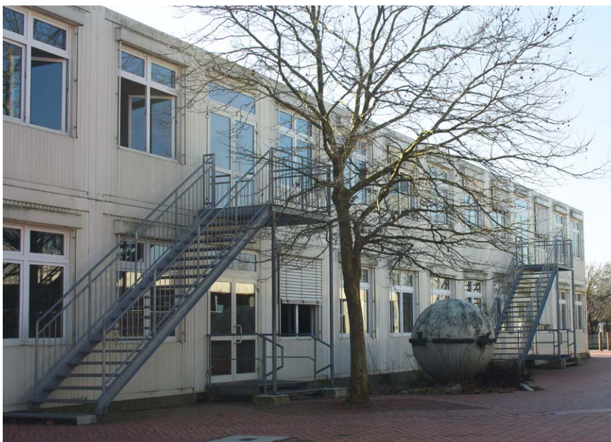
Schule im Container – oft jahrelange Auswechslung bei notwendigen Sanierungsmaßnahmen infolge eines Schadens. Neben diesem grundsätzlich unerfreulichen Umstand kommt es zudem bei Provisorien des Öfteren zu fragwürdigen Situationen. Beispielsweise führen hier im Bild die Fluchttreppen vor ungesicherten Fenstern vorbei.
