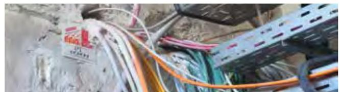
Bild: Öffnungen in Brandwänden und in feuerbeständigen Wänden müssen feuerbeständig durch Kabelschotts wieder geschlossen werden.
