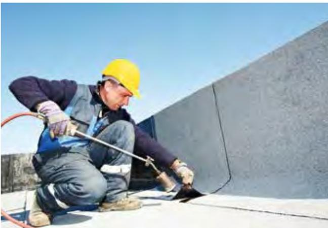
Bild oben: Verlegung einer Bitumen-Schweißbahn, indem die Unterseite der Bitumen-Schweißbahn mit einem Schweiß- oder Gasbrenner angeschmolzen und anschließend auf das Dach gedrückt wird. Diese brandgefährliche Arbeit darf nur unter besonderen Sicherheitsmaßnahmen durchgeführt werden.
