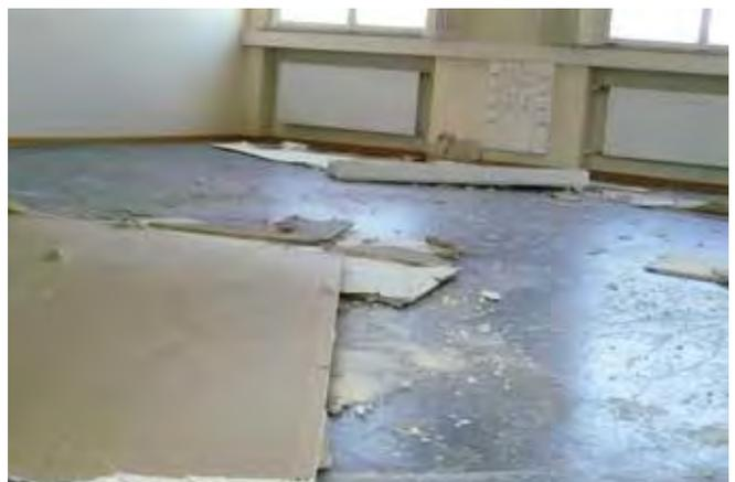
Schadenfall 2: In der Mädchentoilette im 3. OG einer Schule wurde ein Putz-Wasserhahn nicht richtig geschlossen. Wände und Decken bis ins 1. OG wurden stark durchnässt. Aufgrund der späten Entdeckung des Wasserschadens in der Ferienzeit war bereits großflächig Schimmel gewachsen.
