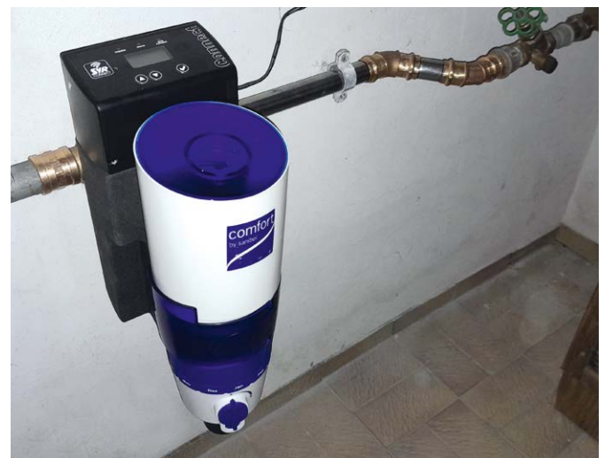
Zu festgelegten Zeiten oder bei atypischem Wasserverbrauch kann die Steuereinheit eine automatische Absperrung der Installation auslösen.
