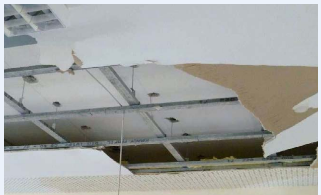
Der Leitungswasserschaden weichte im darunter liegenden Stockwerk die Decke auf. Um Schimmelwachstum aufgrund der Feuchteschäden in den Wänden, Decken und Böden zu vermeiden, mussten diese sofort getrocknet werden. Weitergehende Aufwendungen und Abspernungen wären ansonsten erforderlich geworden.
