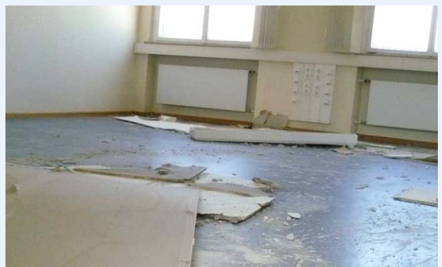
Der Leitungswasserschaden weichte im darunter liegenden Stockwerk die Decke auf. Um Schimmelwachstum aufgrund der Feuchteschäden in den Wänden, Decken und Böden zu vermeiden, mussten diese sofort getrocknet werden. Weitergehende Aufwendungen und Abspernungen wären ansonsten erforderlich geworden.
