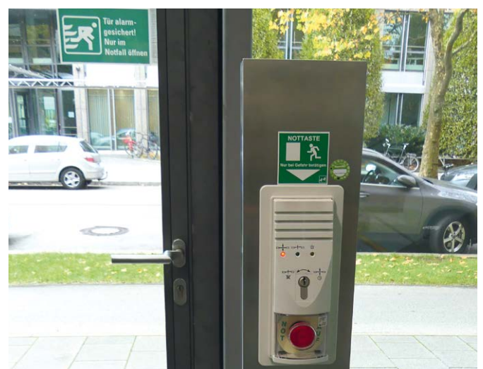
Notausgänge können durch Fluchttürsteuerungen gegen Missbrauch gesichert werden.
