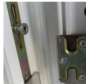
Stabile Fenster mit Pilzkopfzapfenverriegelung bieten Sicherheit. Achten Sie hierauf bei Renovierungsmaßnahmen oder rüsten Sie mit Zusatzsicherungen nach.
