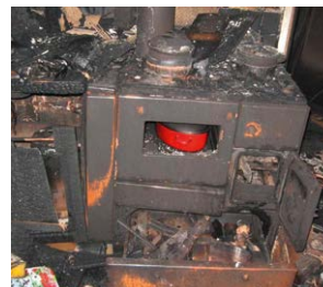
Die vor der Ofentür abgestellte Holzkiste geriet in Brand.
