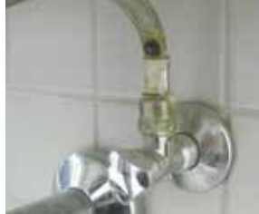
Flexschlauch ist verrostet – ein Wasserschaden wird möglich.
