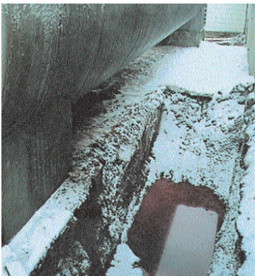
Überfüllschaden an einem oberirdischen Heizöltank
