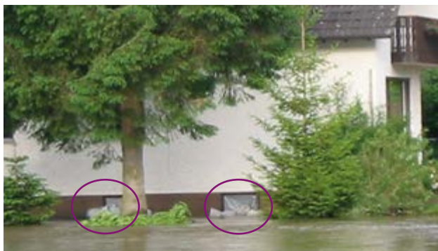
Sandsäcke dienen als provisorischer Schutz der Kellerfenster während einer Überschwemmung.
