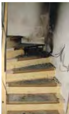
Ölgetränkte Lappen lösten eine Selbstentzündung mit Verrußung aus.
