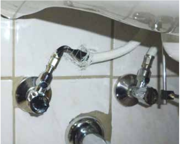
Flexschlauch geplatzt.
