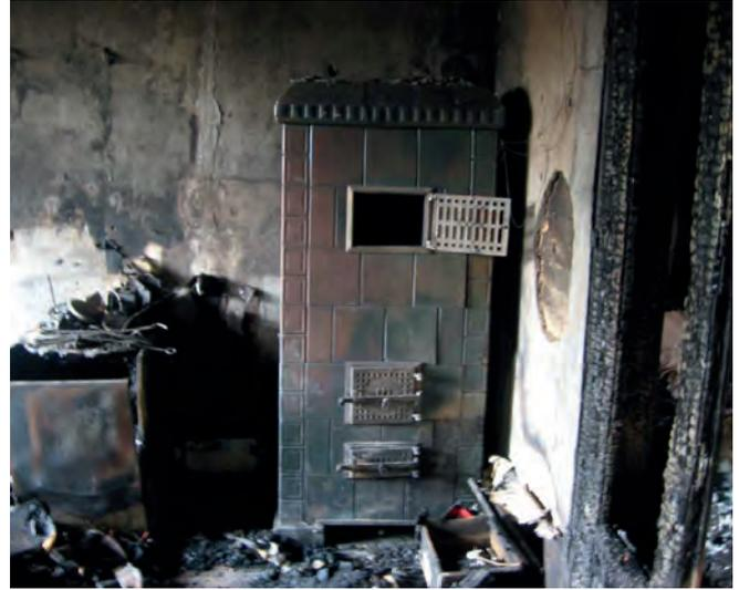
Bild: Die Besitzerin benutze diesen Ofen quasi als „Müllverbrennungsanlage“. Letztlich kam sie mit dem gesammelten Brennmaterial und der Gefahr von herausfallender Glut nicht mehr zurecht: Großbrand
