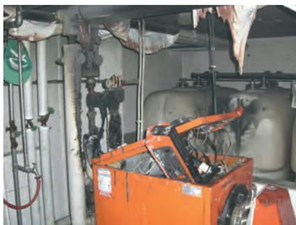
Bild: Explosion eines bereits 23 Jahre alten Öl-Heizkessels.
