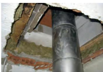
Bild: Zu geringer Abstand zum Abgasrohr. Das Bild zeigt die Situation nach dem Ausschneiden der verbrannten Baustoffe.
