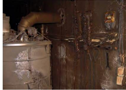
Bild: Auch das gibt es: Ein neuer Pellettschneidofen löste sofort nach Inbetriebnahme einen Brand aus. Der Heizungskeller brannte aus, Verruungen im UG und EG.
