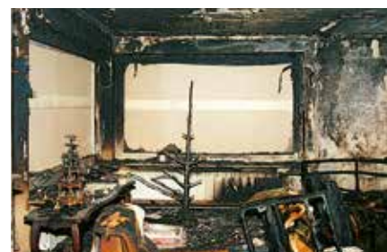
Schadenbild: Ein Christbaum mit brennenden Wachs-kerzen fing schlagartig Feuer. Der Baum war ausgedorrt – die Brandgefahr damit gestiegen.
