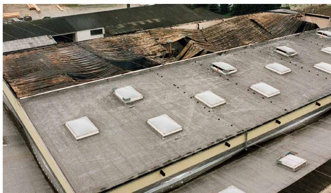
**Brandwand hielt stand** – die Investition in die Brandwand hat sich gelohnt, ein Übergreifen des Feuers auf den nächsten Brandabschnitt wurde verhindert. Dadurch konnten wichtige Teile der Produktion gerettet und der Betrieb aufrecht erhalten werden.
