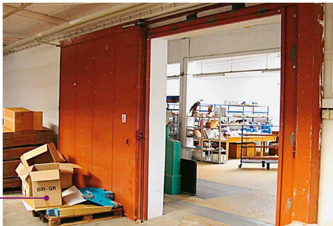
Unzulässige Lagerung an einem Feuerschutztor mit Feststellanlage: Im Brandfall kann das Tor nicht schließen.
