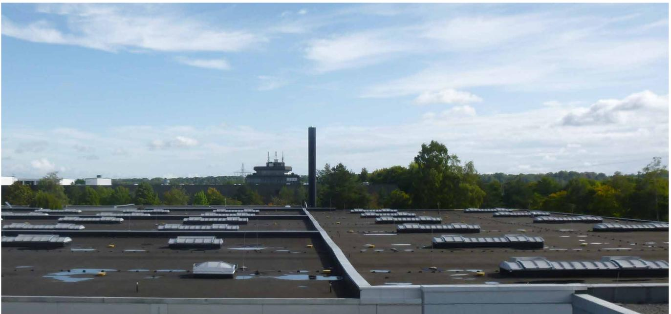
Bauliche Trennung der einzelnen Brandabschnitte durch Brandwände.
