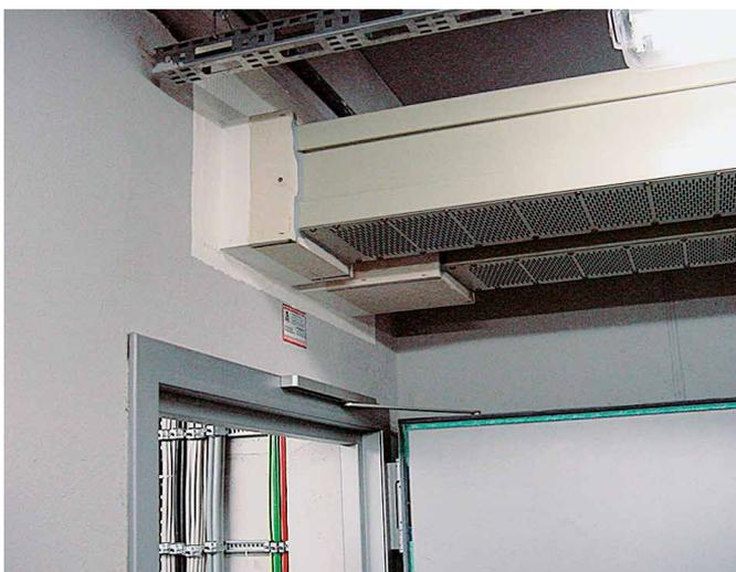
Brandschutzklappe, Bild Firma TROX
